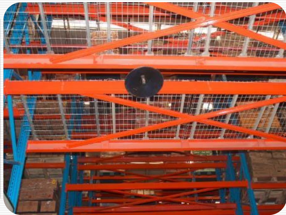
符合要求的挡水板设置
